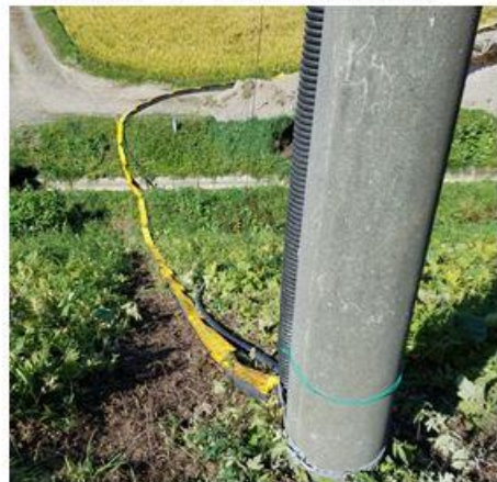
土砂崩れ区間の暫定ケーブル敷設
