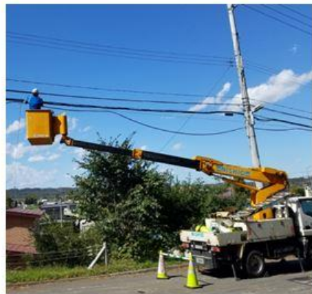
迂回ルートへのケーブル敷設
