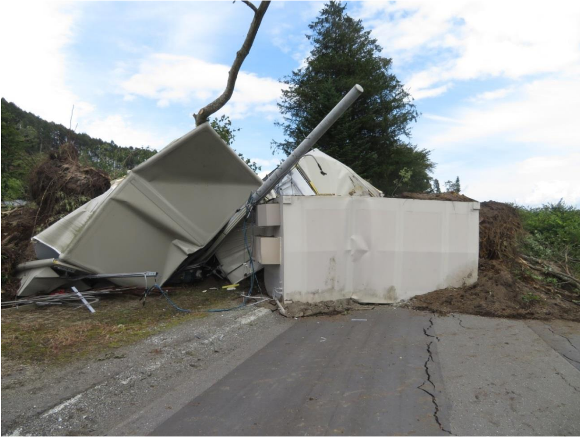
土砂災害の影響により倒壊した幌内ビル
